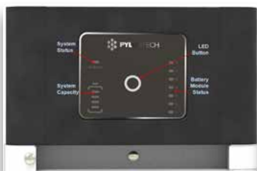
Display del BMS
